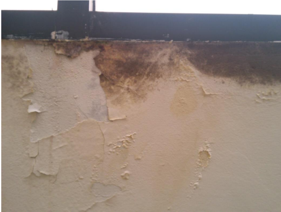
Slika 8. Znakovi vlage/plijesni unutar školske zgrade na području Osječko-baranjske županije
