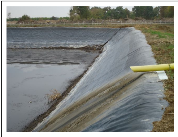
Slika 11. Ulaz tekućeg dijela gnojovke u lagunu
