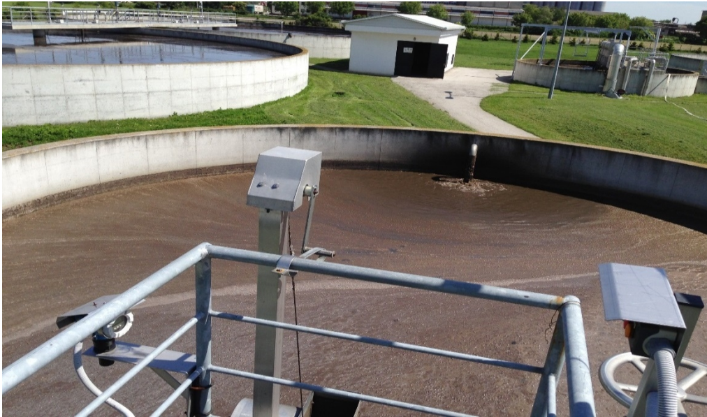
Slika 11. Ugušćivač mulja UPOV „Jošine“
