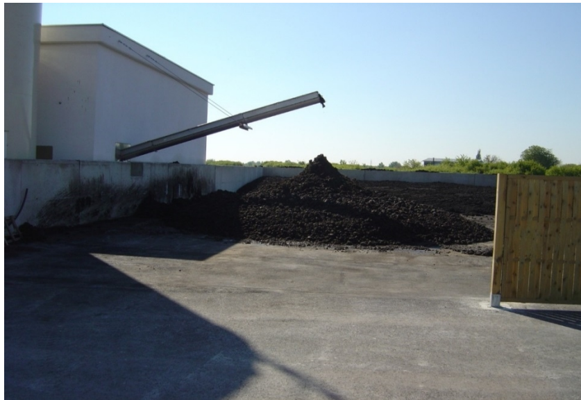
Slika 13. Sanitarna deponija za otpadni mulj UPOV „Jošine“
