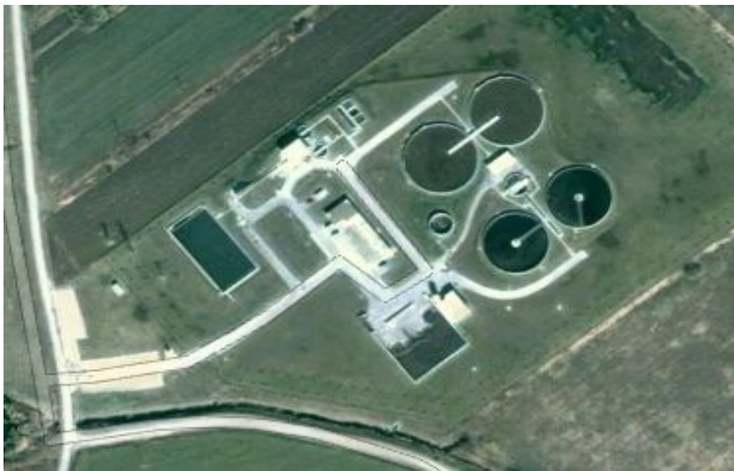
Slika 1. Uređaj za pročišćavanje otpadne vode „Jošine“
