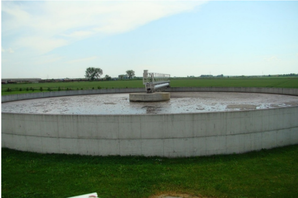
Slika 8. Sekundarni taložnik UPOV „Jošine“
